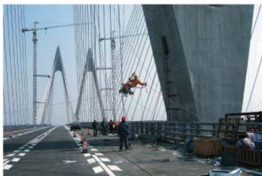
斜拉桥索力调整测试
