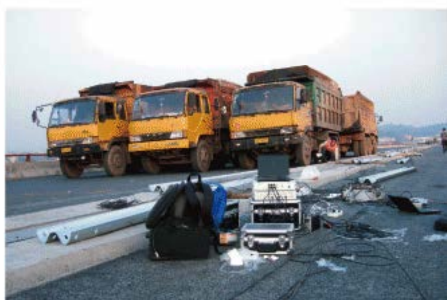
桥梁竣工动载试验
