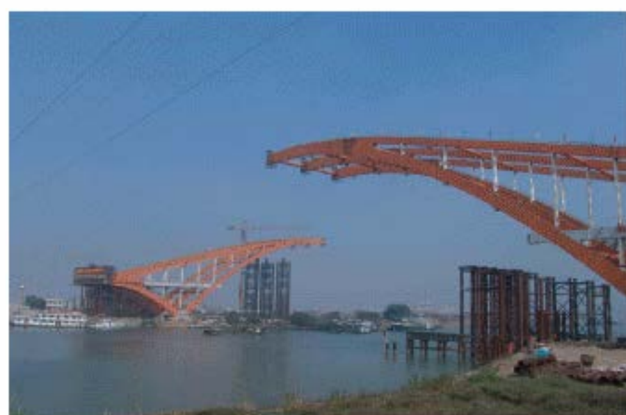
拱桥转体施工振动稳定性控制
