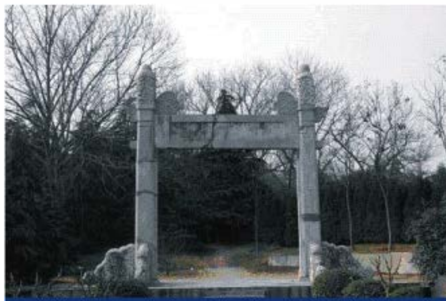
地铁施工冲击对文物建筑影响评定
