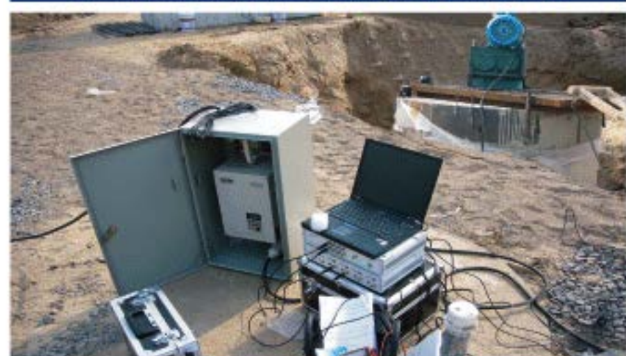
桩基础抗压及抗弯刚度测试
