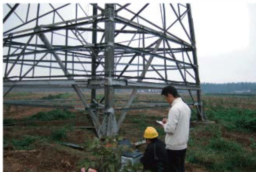
耐张塔基础加固改造应变试验
