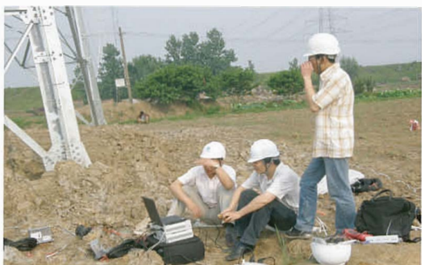
溧水500KV输电塔整体及局部模态试验 (2008年06月12日)
