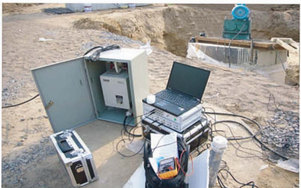
特高压巩义过黄河输电塔基桩动力特性 (2007年01月16日)
